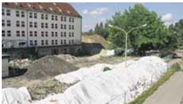
Abb. 18: Beim Flächenrecycling von ehemaligen Militär- oder Industriestandorten sind ggf. Altlasten zu sanieren.
